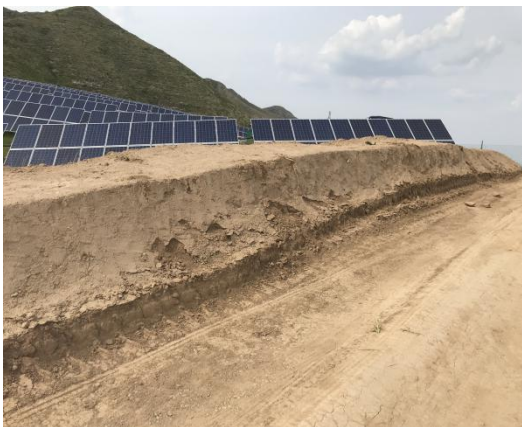
检修道路挡水土埂
