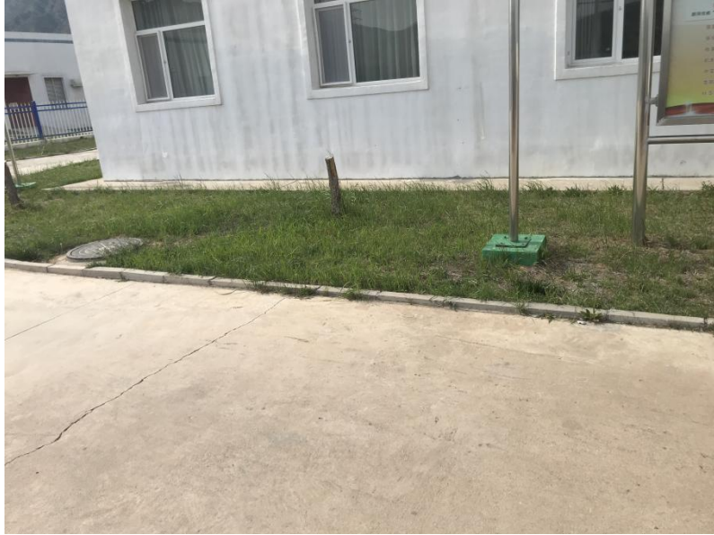
升压站内绿化及路面硬化
