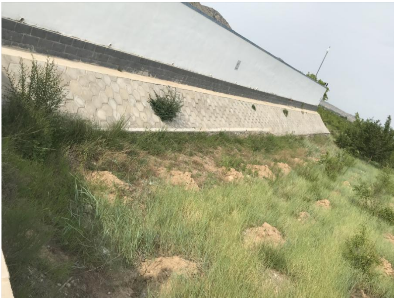
升压站外浆砌石护坡及植物生长情况
