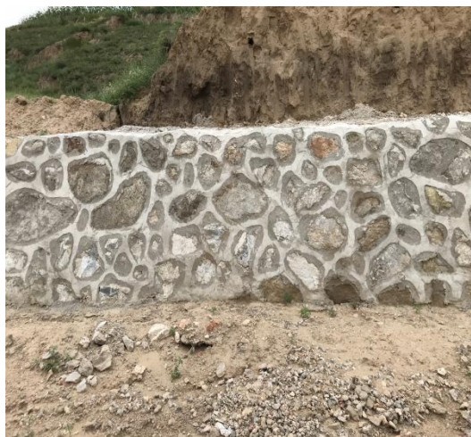
施工检修道路浆砌石护坡
