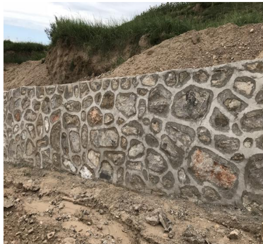
施工检修道路浆砌石护坡
