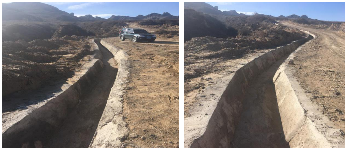
混凝土排水沟
