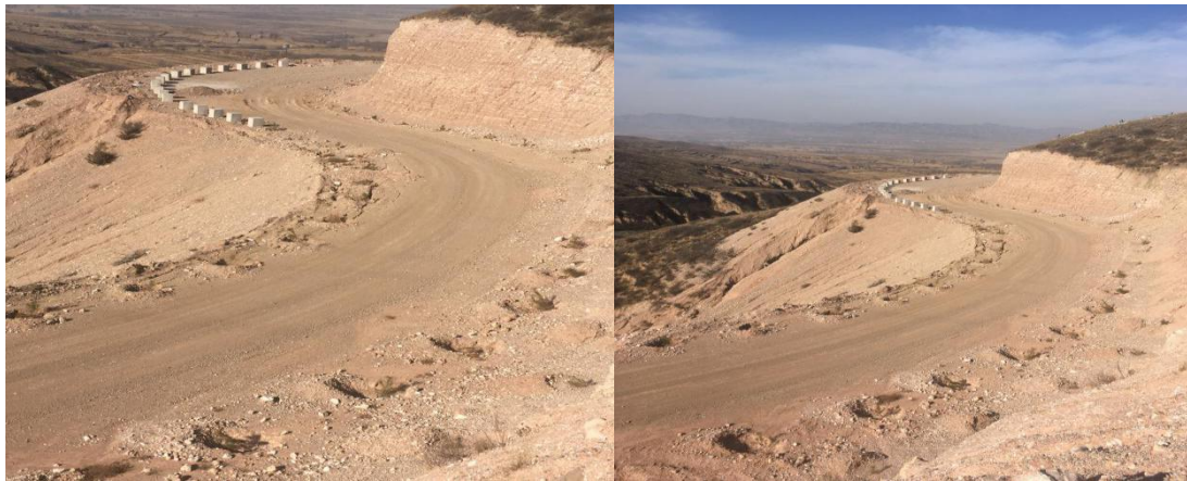
施工检修道路平整
