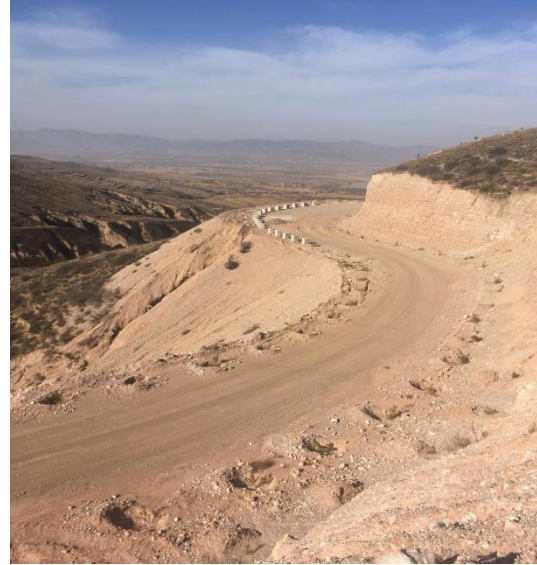
施工检修道路平整
