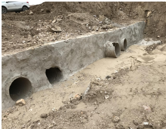
施工检修道路浆砌石护坡
