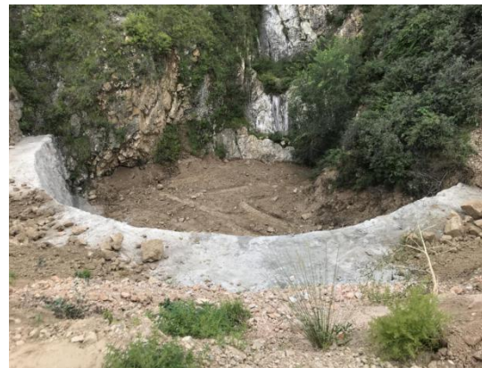
施工检修道路浆砌石护坡
