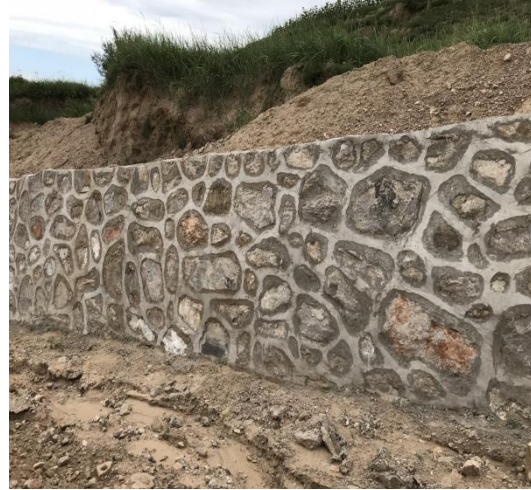
施工检修道路浆砌石护坡
