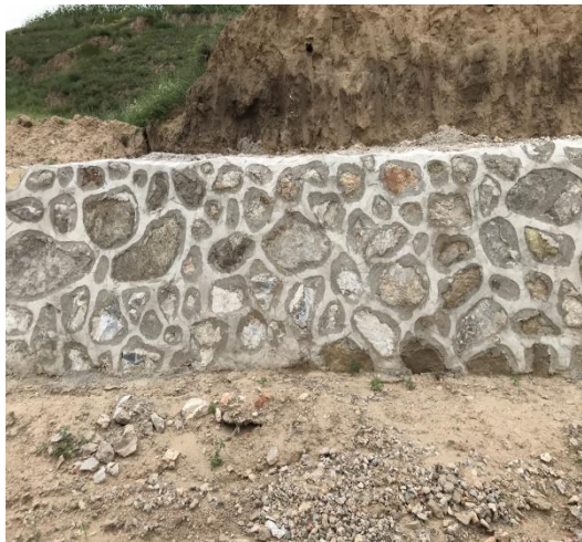
施工检修道路浆砌石护坡
