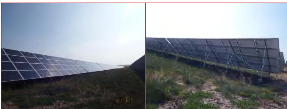
光伏架设区双排预制桩支架基础
